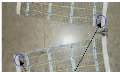
Нить нагрева (желтый провод) резать нельзя!
